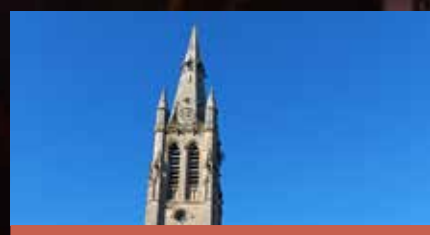
LA TOUR CLOCHER DE SAINT-MARTIN EN TRAVAUX
