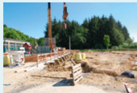
Début des travaux à Fouches
