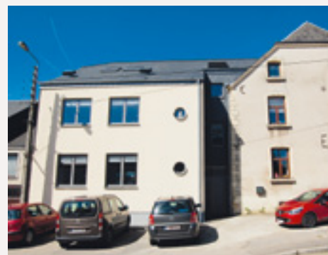
Extension à Heinsch - vue de la rue
