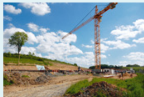
Travaux à Sterpenich-Barnich
