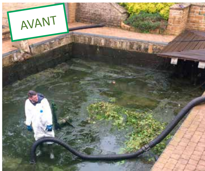
Chaque année, au printemps, le service environnement fait procéder au nettoyage des sources de la Semois. Les travaux consistent à vidanger le bassin, évacuer les algues, aspirer la boue (la vase), passer le nettoyeur à haute pression, nettoyer les pompes.
