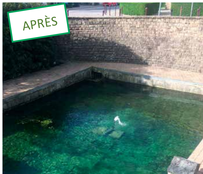
Chaque année, au printemps, le service environnement fait procéder au nettoyage des sources de la Semois. Les travaux consistent à vidanger le bassin, évacuer les algues, aspirer la boue (la vase), passer le nettoyeur à haute pression, nettoyer les pompes.
