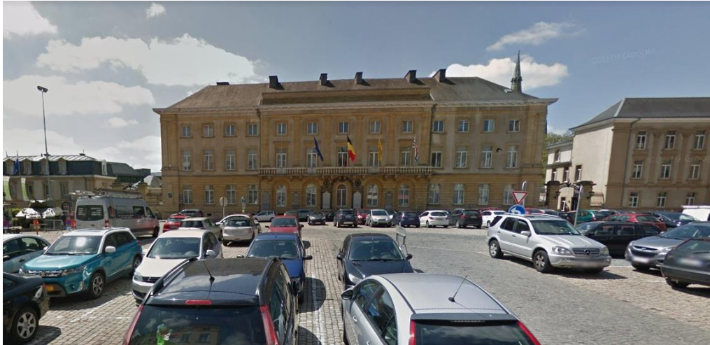
Vue 3 – Limites du bien concerné (situation avant remplacement des châssis)
