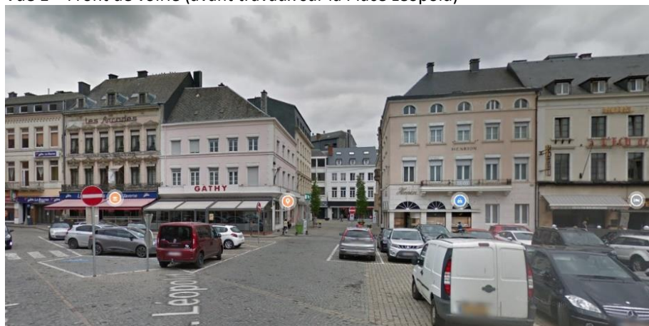
Vue 1 – Front de voirie (avant travaux sur la Place Léopold)
